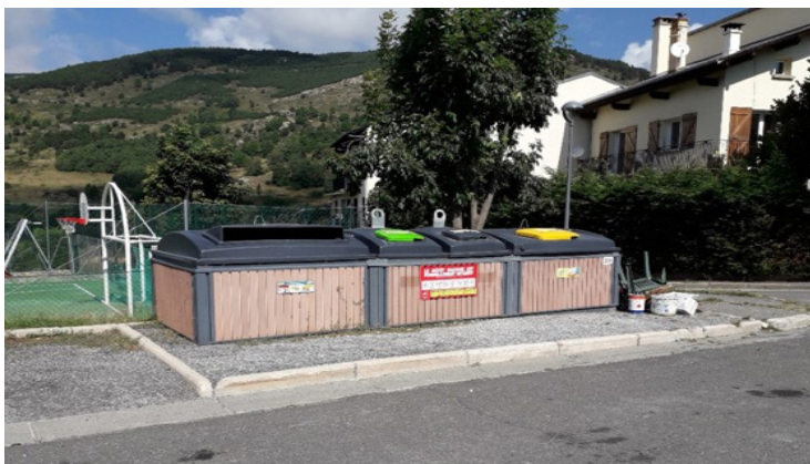
Exemple de conteneur semi-enterré.
